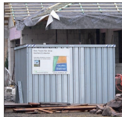
Typisches Baustellenbild: SC3000 als Material-, Wetter- und Diebstahlschutz.
