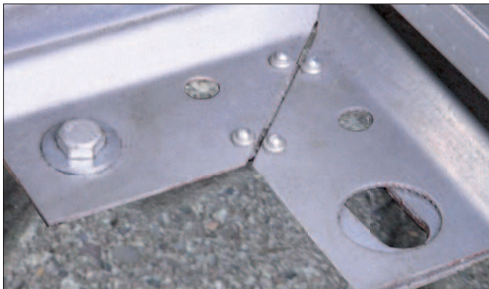
Bodenbefestigung mit Erdnägeln oder Dübeln
